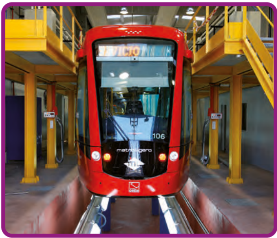
Nave de servicio
