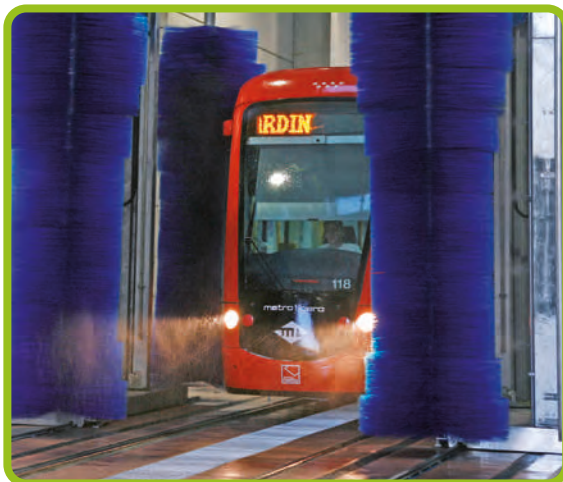
Nave de lavado
