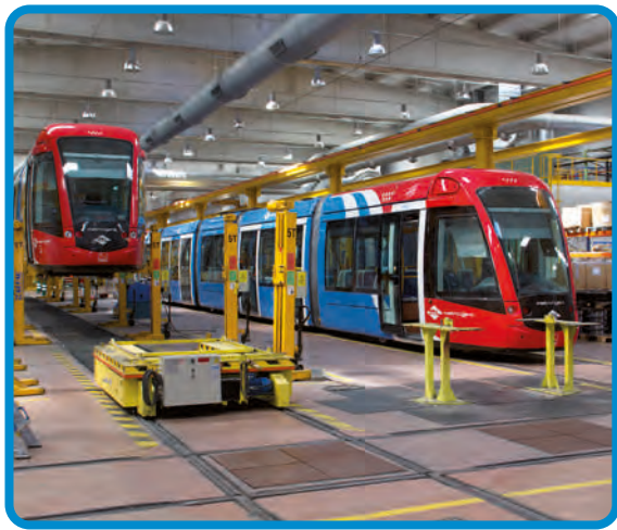
Taller de mantenimiento
